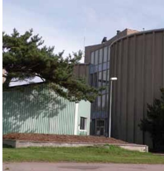
Biogaskammare vid Västra strandens reningverk.
