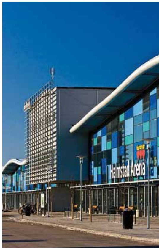
Isen i Halmstad Arena tillverkas av fjärrvärme från Kristineheds avfallsförbränningsanläggning. Spillvärmern från absorptionskylmaskinerna används sedan för att värma ventilationsluften i arenahallen.
